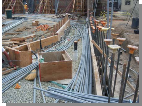
Under Slab Conduits
